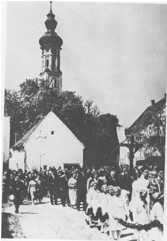
Pfarrkirche St. Martin von Süden, mit Glöckler-Haus und Pfarrhof
