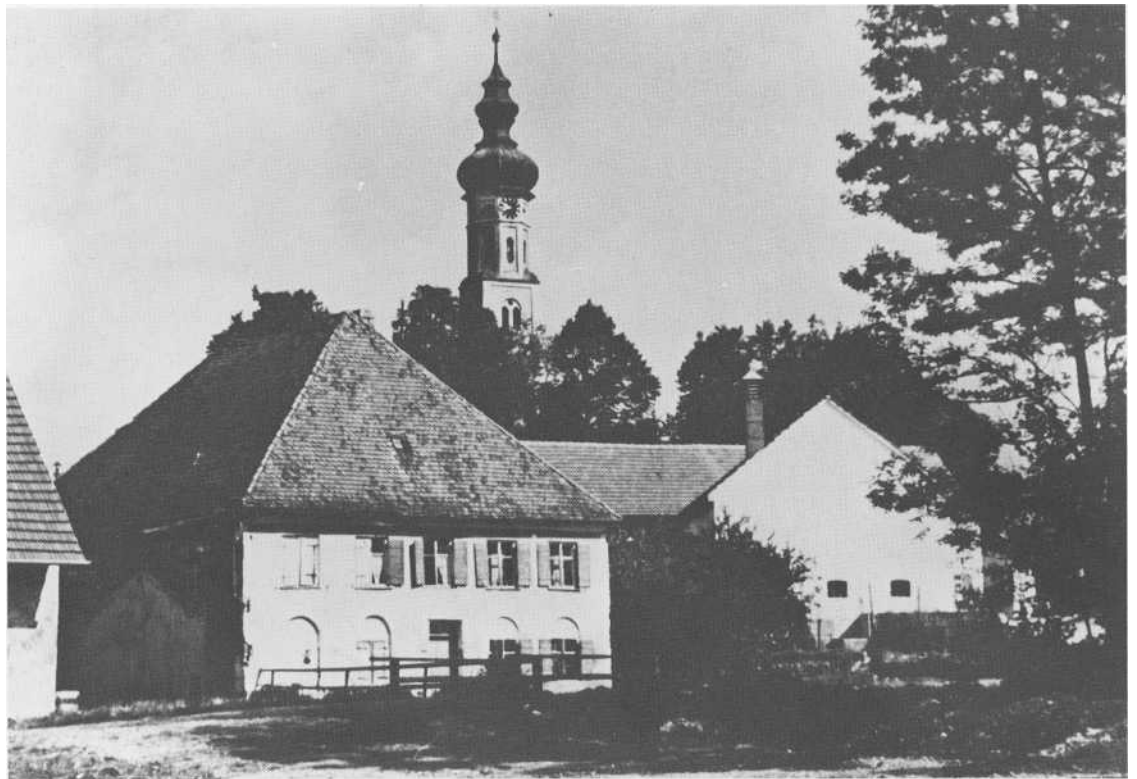
Die Mühle (jetzt Raiffeisengelände), im Hintergrund der St. Martins-Kirchturm
