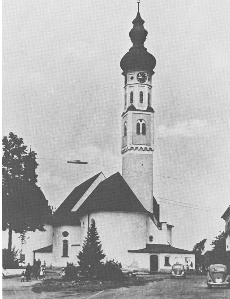
St. Martins-Kirche nach dem Umbau (rechts der alte Pfarrhof)
