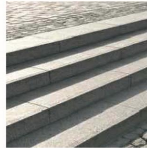
Treppe Wassertreten Blockstufen Granit
